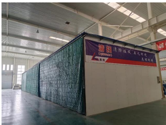
项目密闭隔间
